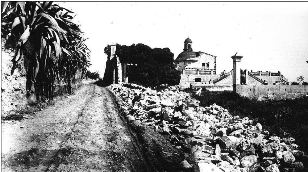
En primer terme el Camí de Dalt o Travessera de Gràcia. A la dreta l'església de Can Xifré, i l'edifici principal ja pràcticament enderrocat. Foto de l'Arxiu Històric de Sant Pau 3
