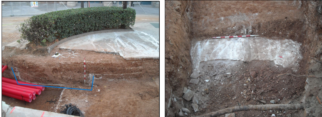
Estructura transversal pavimentada localitzada en la rasa 200B i detall de la pavimentació
