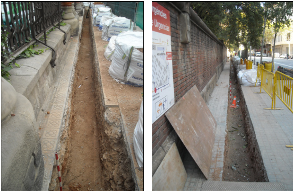
Rasa 7000 a l'altura de l'accés principal i a partir de l'antiga entrada d'Urgències a l'Hospital.
