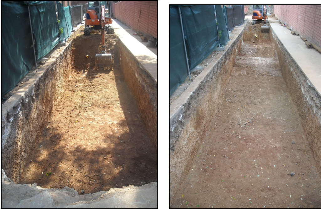
Procés d'obertura del tram inferior de la rasa 300A
