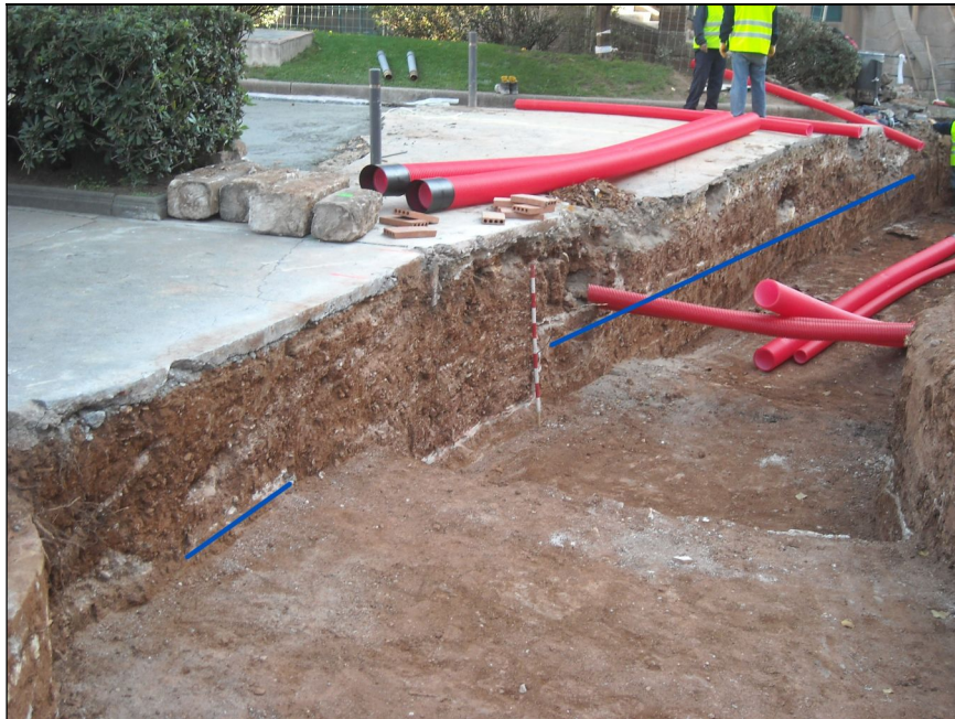
Nivell de circulació (marcat en blau) detectat en la rasa 400B
