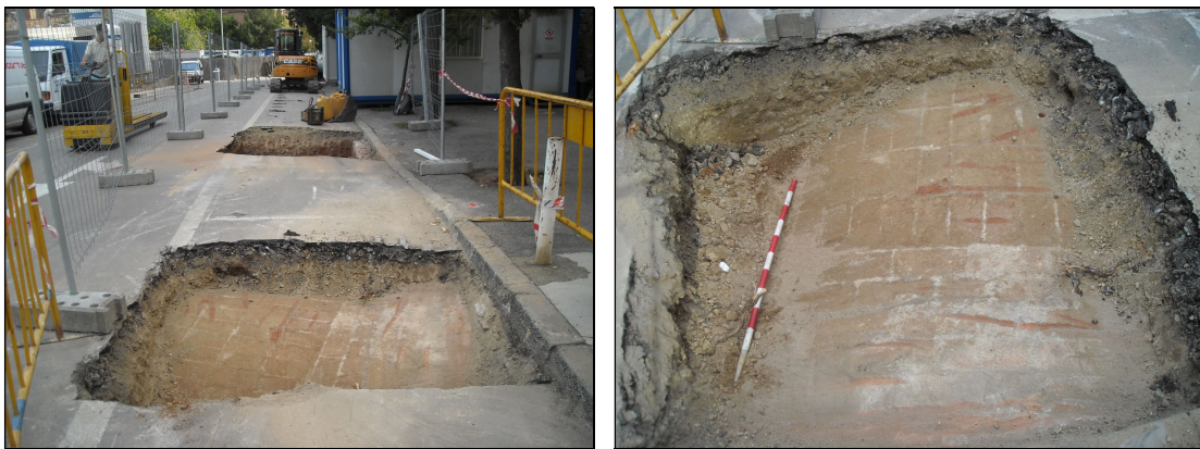
Sondejos localitzats a l'oest de la rasa. Detall de la volta del passadís d'un dels passadissos subterranis.
