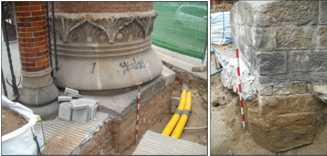
Detall de les fonamentacions dels pilars que emmarquen l'accés principal a l'Hospital.
