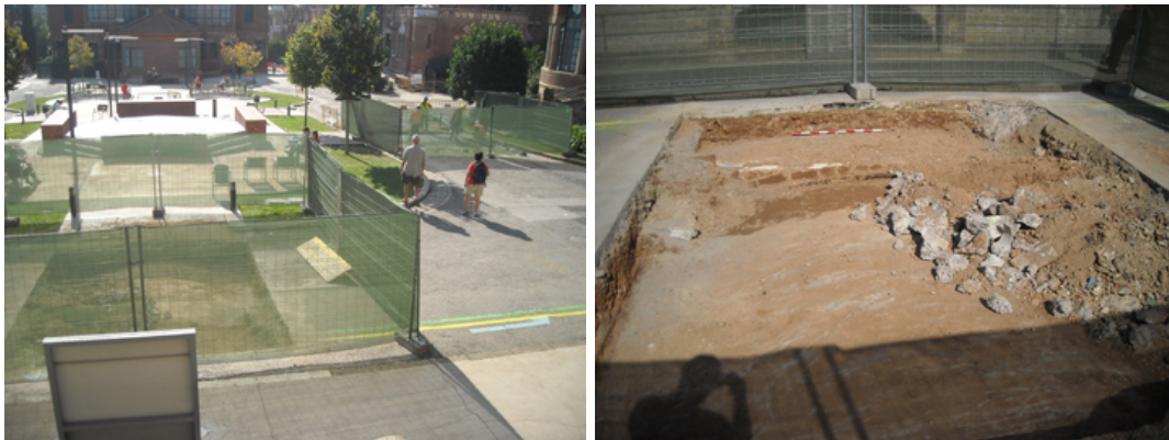
Vista del sondeig 5400 i detall de la part descoberta de la volta en aquest sondeig.
