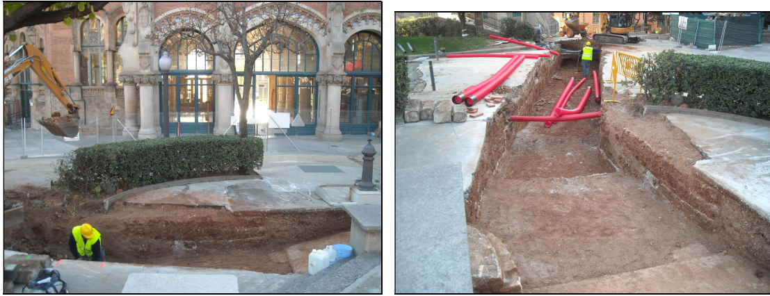
Vista del tram central de la rasa 400B i del segment est d'aquesta rasa.
