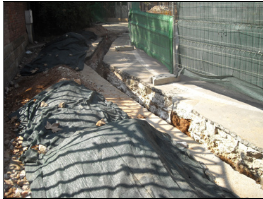
Vista de la rasa 4000 amb la solera retallada als perfils.
