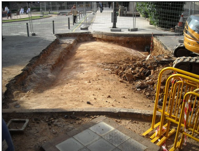
Detall del sondeig 5300 amb la volta de la galeria subterrània.
