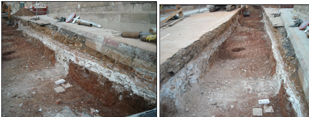
Vista als perfils de la rasa 400C de la solera i d'un dels nervis/fonamentació de la solera.
