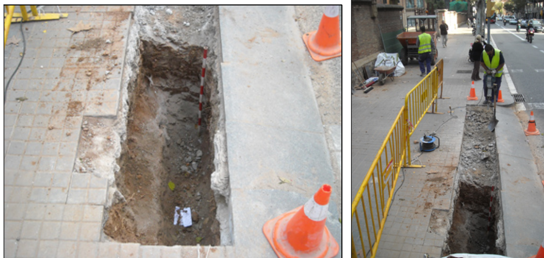
Detall del procés de realització de la rasa 7300.
