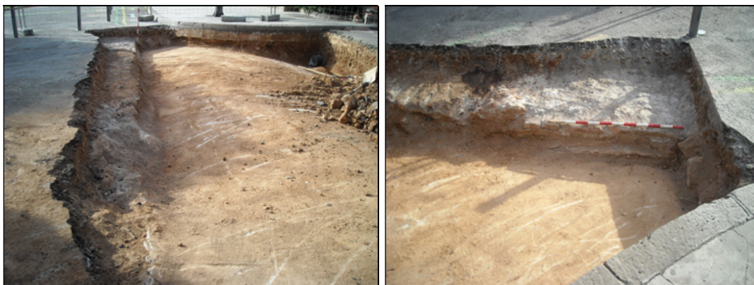
Detalls de la part de la volta descoberta durant la realització del sondeig 5500.
