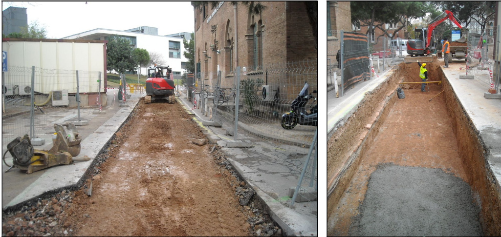
Rasa 300C durant l'obertura de l'asfalt i una vegada s'ha rebaixat fins a la cota necessària.
