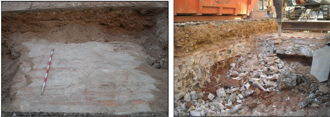
Detall del paviment de la bassa i del conjunt de la solera/paviment durant el procés de desmuntatge.
